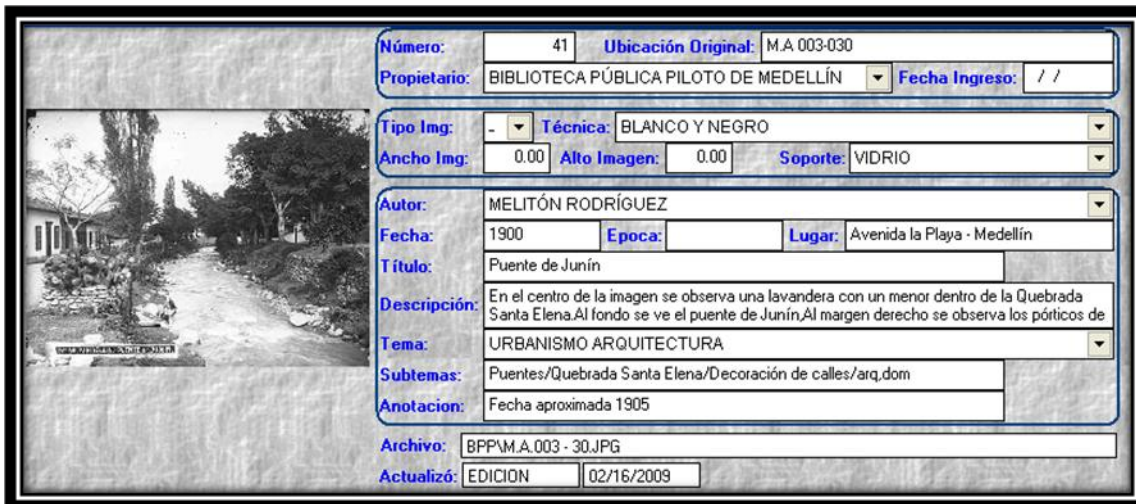
Imagen 41. Puente de Junín, ca. 1905.
