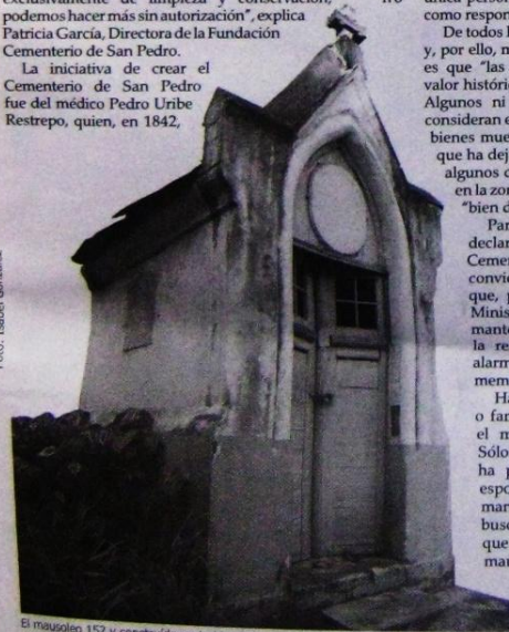
El mausoleo 152 y construido probablemente por Horacio Rodríguez a finales del siglo XIX, con arquitectura y materiales de la época como boñiga, cal y tejidos naturales.
