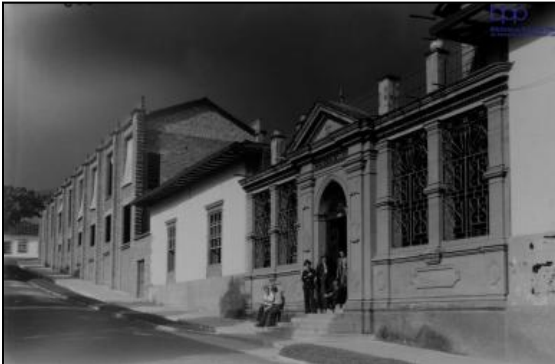
Imagen 51. Escuela Nacional de Minas, Medellín. 1939 Autor: Fotografía Rodríguez Fuente: Archivo Fotográfico Biblioteca Pública Piloto.
