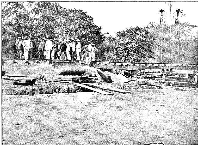
Puente sobre el río Fundación
