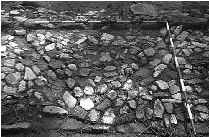
Figura 3. Detalle empedrado corredor frontal
